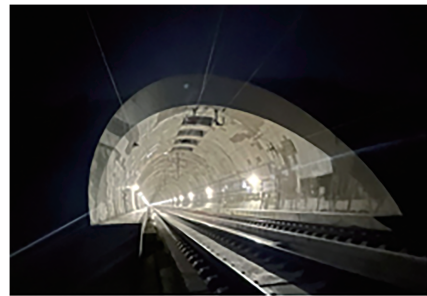
(a) 隧道进口
