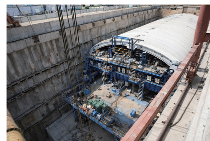
(c) 车站施工实景图
