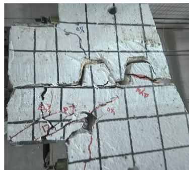
(b) 侧墙 1 和底板 1 榫头连接处
