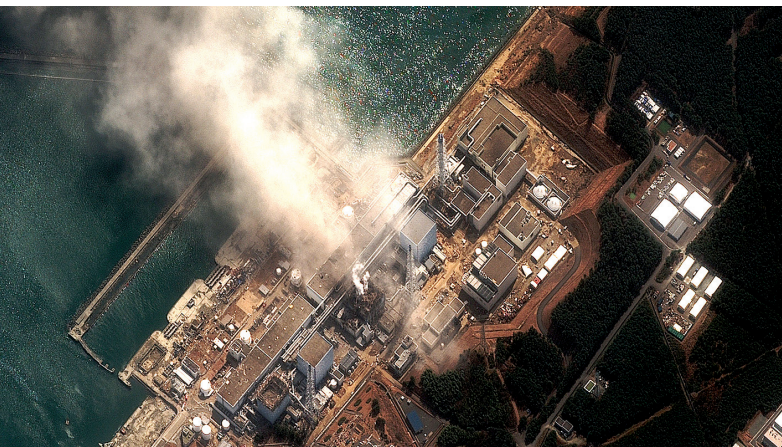
在地震和海啸中受损的福岛核电站
