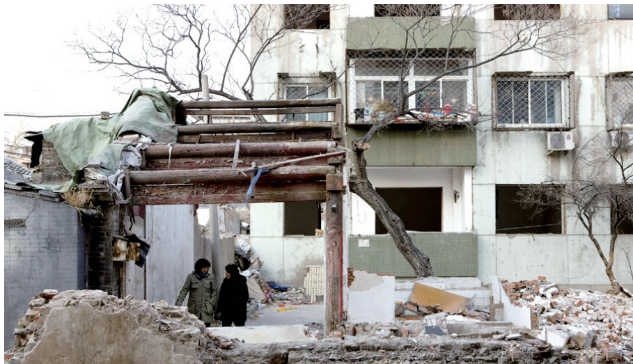
梁思成故居被“维修性拆除”（2011年12月）
