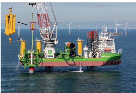
图 14 海上风机分体式安装法实例照片 [45]
