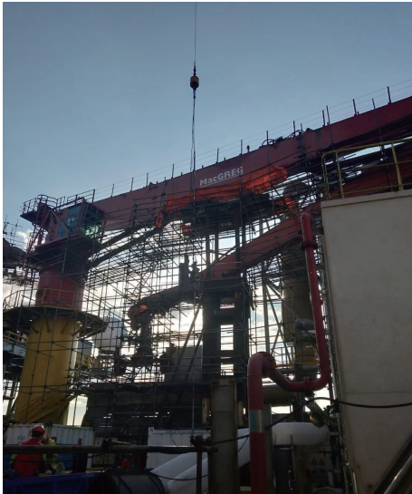
图 18 海洋平台吊装施工现场照片 [53]
