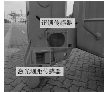
图5 实验设备安装
