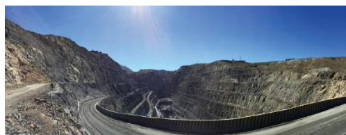
(a) 露天矿边坡全貌
