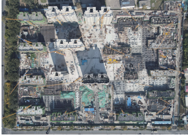
图1 施工现场塔吊布置
