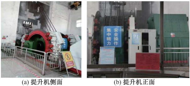
图 2 现场实物 Fig. 2 On-site physical object
