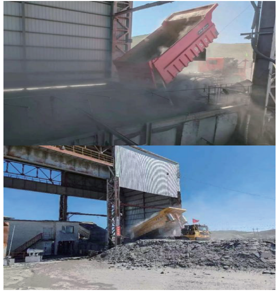
图 1 破碎站单边和双边卸料作业
