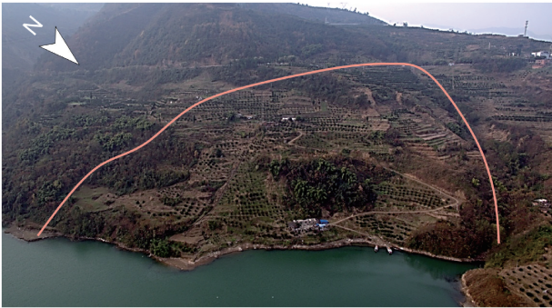
(a) 渣口石滑坡实景
