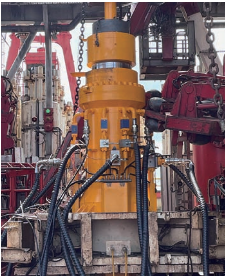
图 6 隔水管多功能悬挂系统海试
