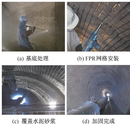
图3 FRP网格结构隧道加固过程 [47]
