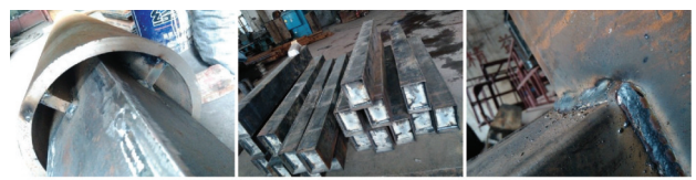
(a) 柱制作加工 (b) 梁制作加工 (c) 梁-柱焊接 (a) Column fabrication (b) Beam fabrication (c) Beam-column welding
