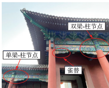
图1 仿古建筑梁-柱节点示意图
