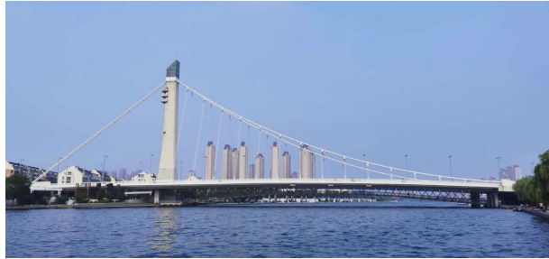
图2 天津富民桥 Fig. 2 Tianjin Fumin Bridge
