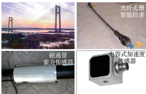
图 1 天津永和桥及监测传感器 Fig. 1 Tianjin Yonghe Bridge and monitoring sensors
