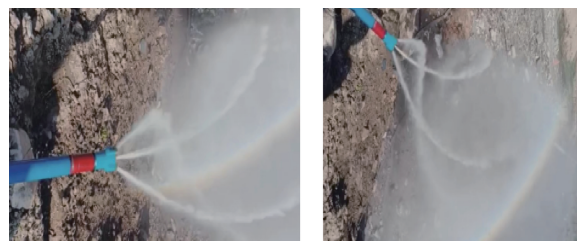
图 8 水力旋转喷射现场试验 Fig. 8 Field test of hydraulic rotary jet
