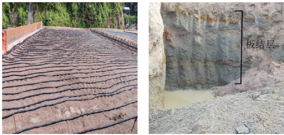
图1 新堆及矿堆板结情况
