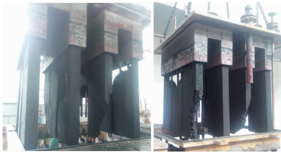
图 3 10 kA 中温电解槽碳板损坏情况
