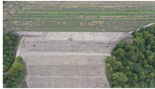
图1 尾矿库初期坝及堆积坝
