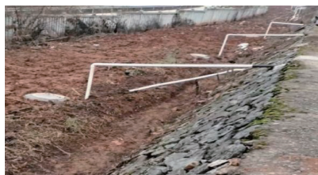
图 4 第一坝段正面排渗管
