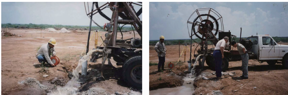
图 1 美国地浸铀矿山成井过程潜水泵抽水洗井照片
