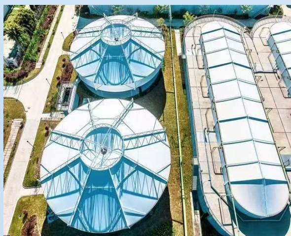
大型商用微生物发电污水处理站
