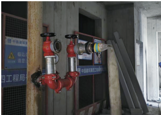
图3 利用混凝土泵管作为干式消防竖管 Fig. 3 Using concrete pump hoses as dry fire standpipes
