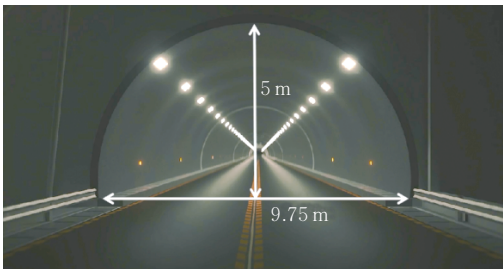
图3 雪峰山隧道尺寸
