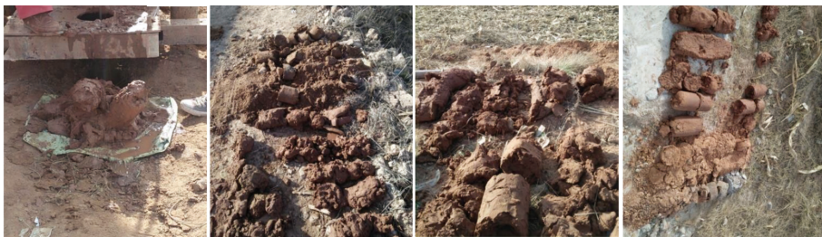
图2 现场钻孔取样路基土体形成了软弱层
