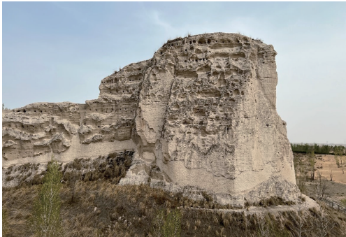
图1 统万城遗址夯土墙
