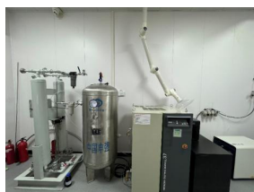
图 2 从右到左分别为:无油空压机,储气罐,干燥器
