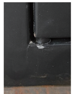
(n) 后门梁柱节点焊缝裂缝延伸
