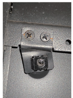
(j) 侧板连接构件屈曲加深
