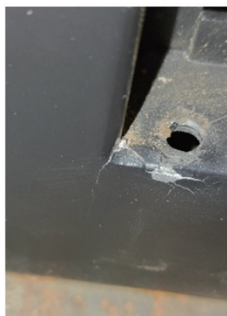
(f) 后门梁柱节点焊缝开裂
