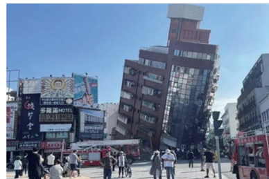
图15 花莲县天王星大楼发生倾斜 [4]
