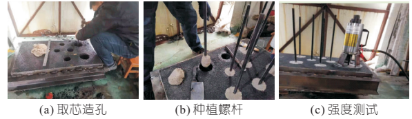
图 3 锚固区强度试验过程
