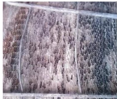
图 1 空预器换热元件堵塞
