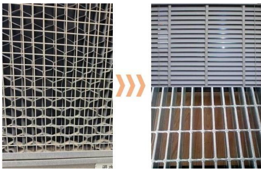
图11 蒸发冷却器防尘网改进示意
