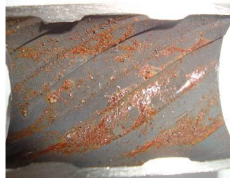
图1 水冷壁管停用氧腐蚀
