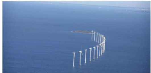
图 5 海上风电机组 Fig.5 Offshore wind turbines
