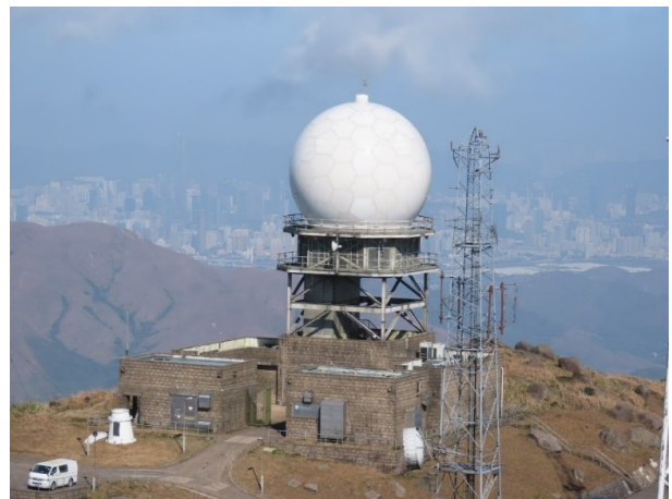
图 14 2024 年位于大帽山的双偏振 S 波段天气雷达 Fig. 14 The dual-polarization S-band weather radar at Tai Mo Shan in 2024
