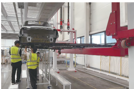
图11 1.8 m处安装行走轮工装
