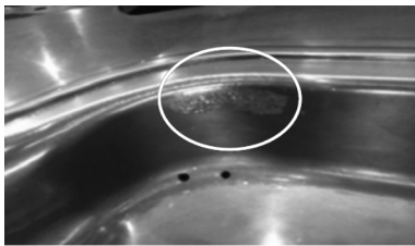
图14 立面间隙过小
