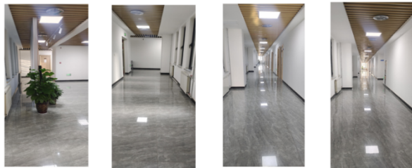
(a) 西侧小走廊 (b) 东侧小走廊 (c) 北侧长走廊 (d) 南侧长走廊
