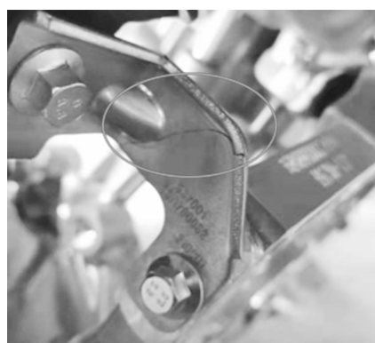
图3 同类型试验支架开裂
