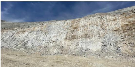
图4 爆破后预裂面整体效果图
