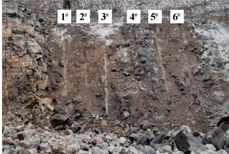
图4 光爆孔试验现场
