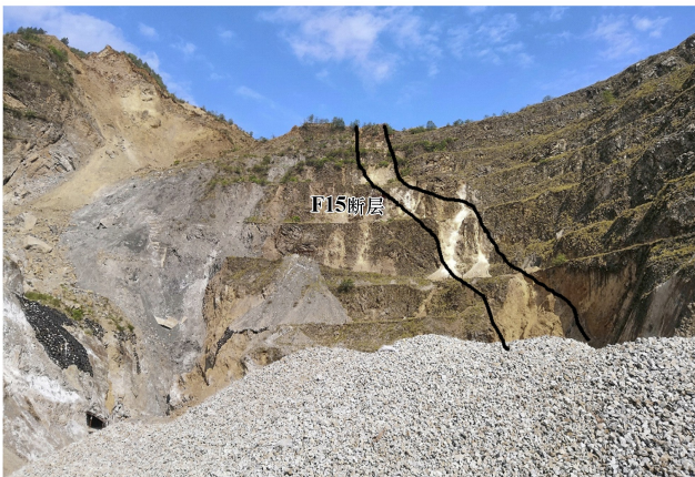
图1 露天北部边坡出露F15断层
