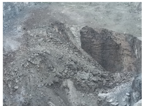
图 13 现场爆破爆堆
