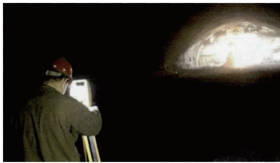
(a) 拱顶下沉监测
