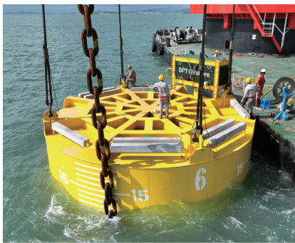
图2 “国能共享号”吸力锚安装施工
