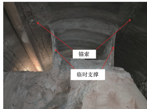
(b) 拱顶锚索施作
