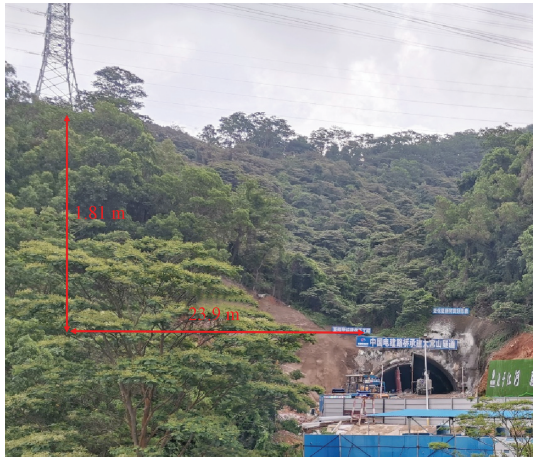
图 13 大常山隧道施工现场
