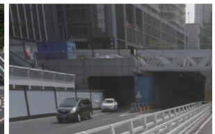
(d) 千厮门隧道出口段
