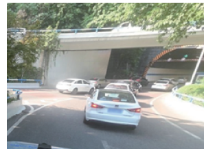
(a) 石黄隧道入口段
