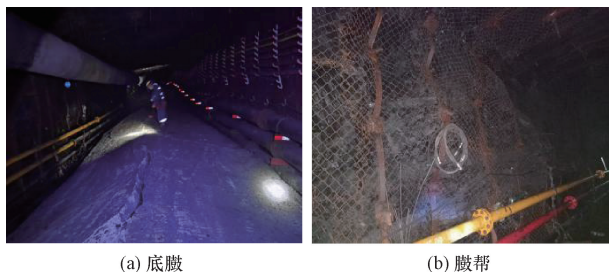
图 2 1012007 巷道变形破坏图
